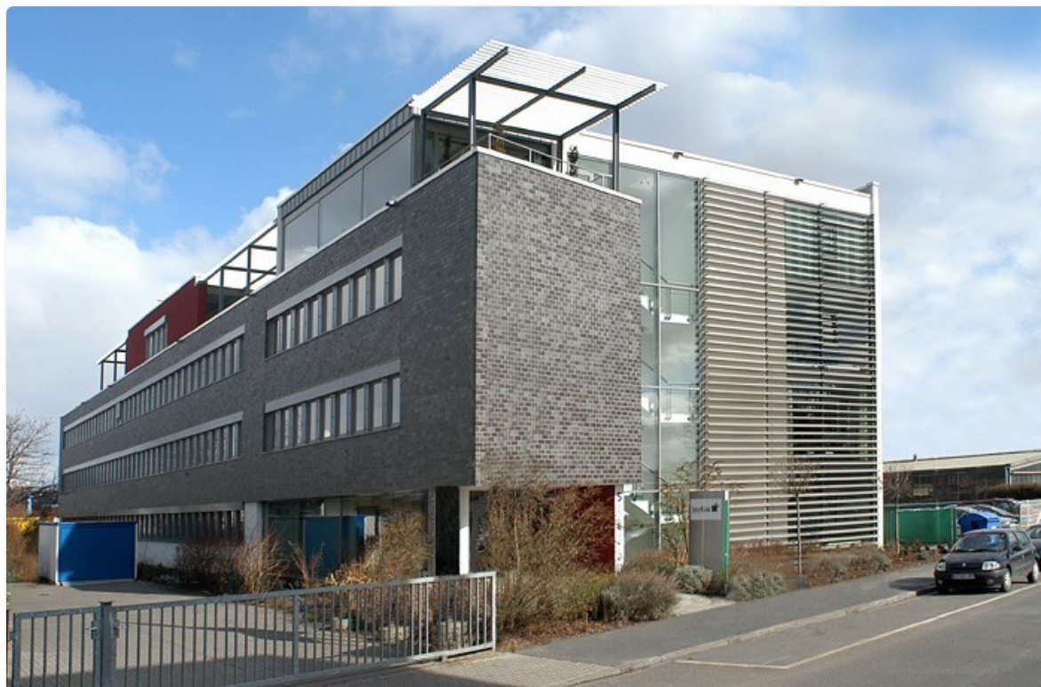
InterRisk Gebäude in Wiesbaden
