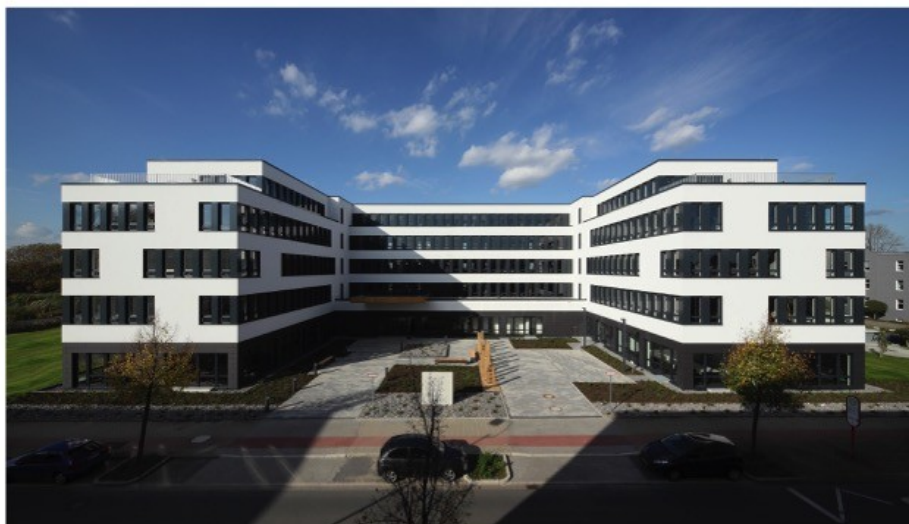
Die Unternehmenszentrale von adesso in Dortmund (Quelle: adesso AG)
