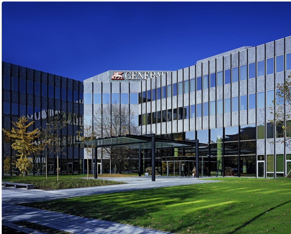
Generali Deutschland - Gebäude in München
