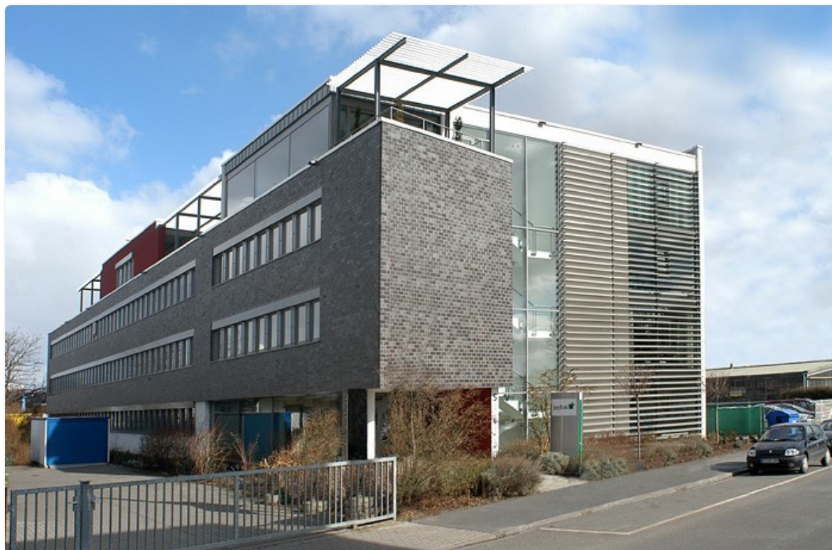
InterRisk Gebäude in Wiesbaden
