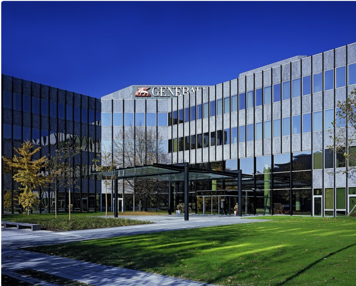
Generali Deutschland - Gebäude in München
