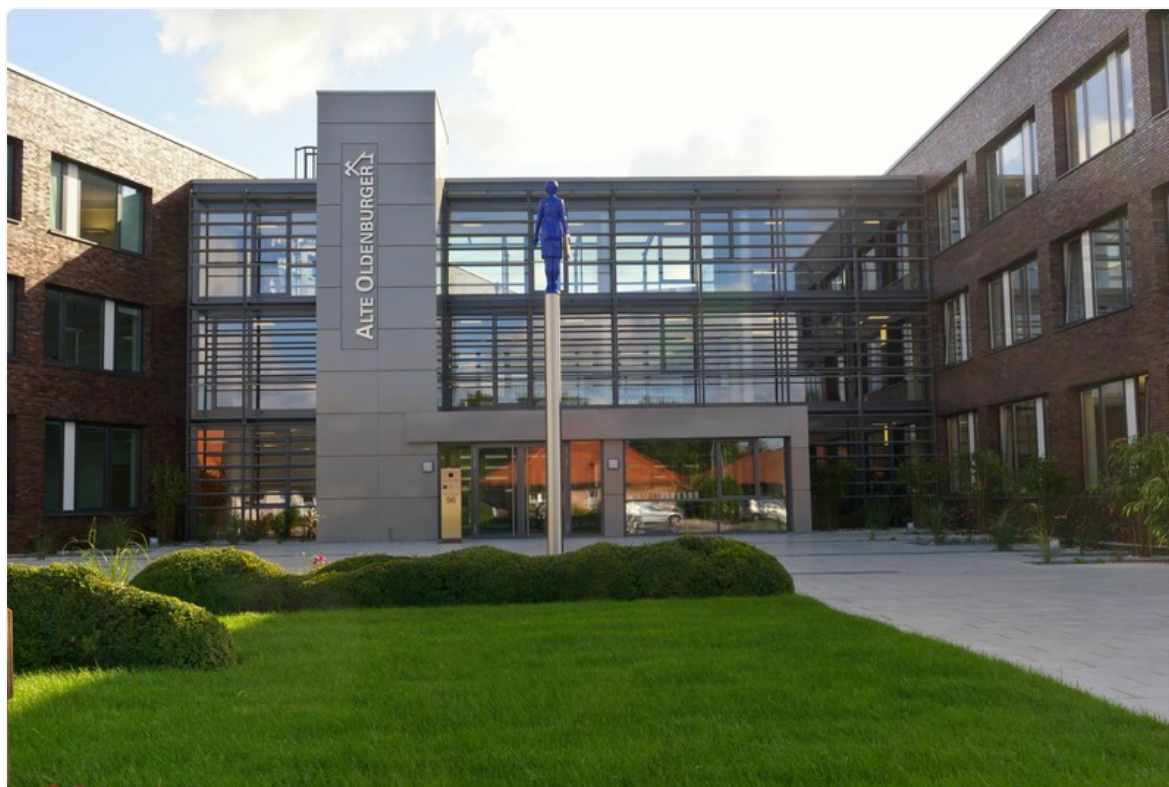
ALTE OLDENBURGER Verwaltungsgebäude mit © ALTE OLDENBURGER Krankenversicherung AG Haupteingang
