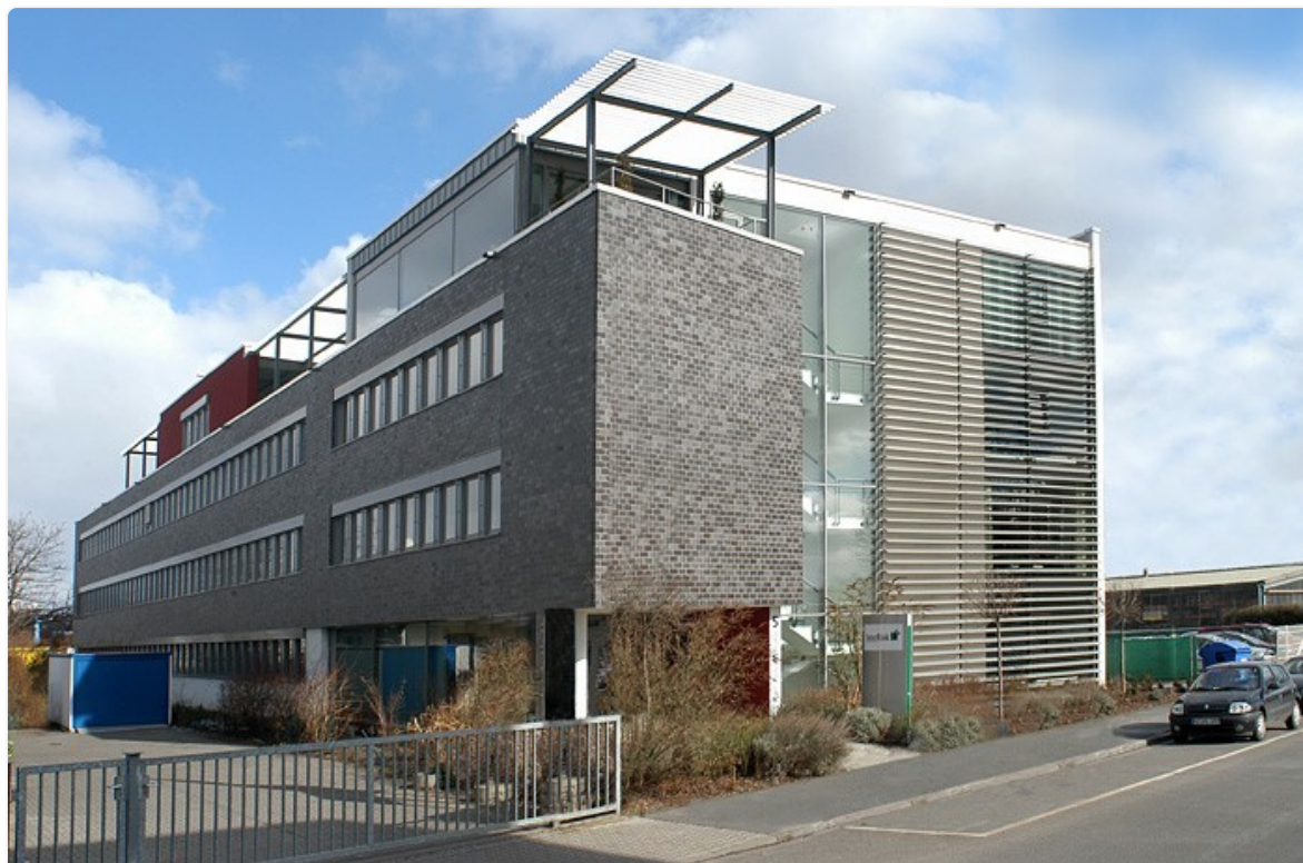
InterRisk Gebäude in Wiesbaden
