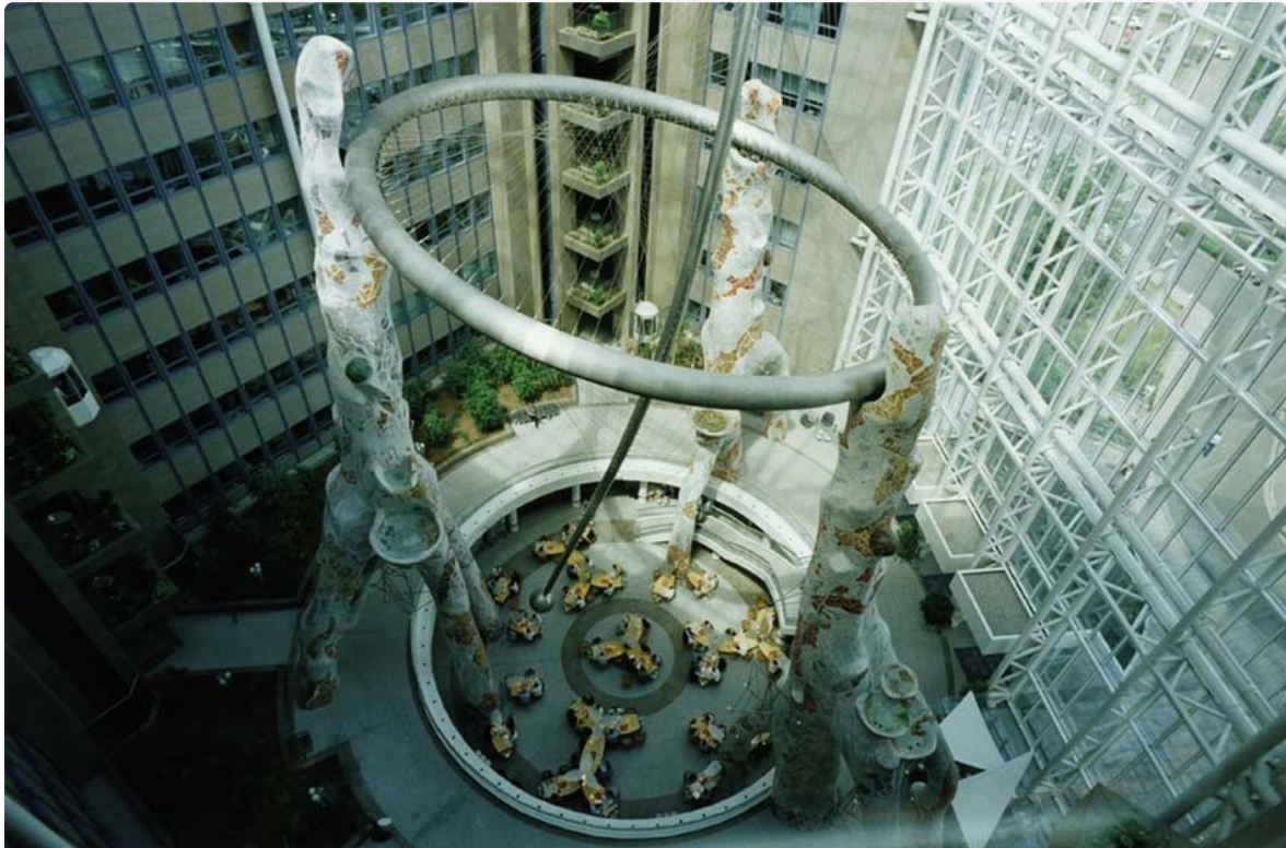
Atricom-Gebäude in Frankfurt am Main
