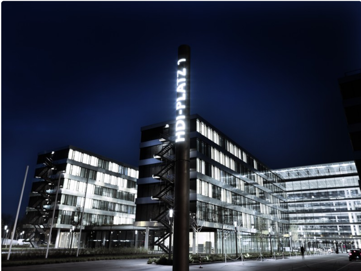
HDI Versicherung AG, Gebäude in Hannover
