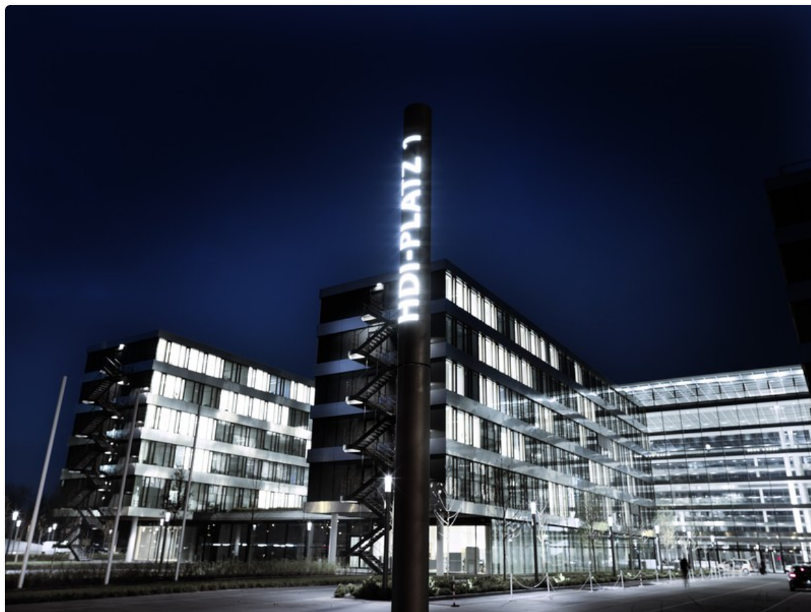
HDI Versicherung AG, Gebäude in Hannover
