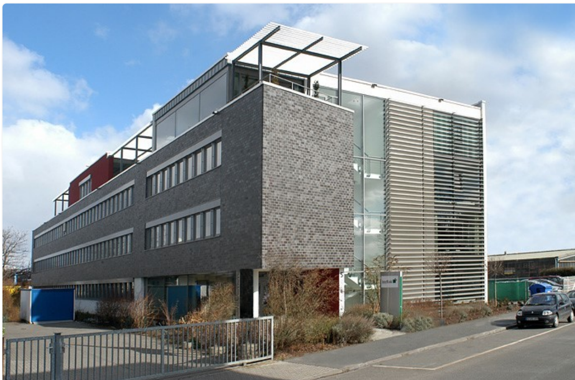
InterRisk Gebäude in Wiesbaden
