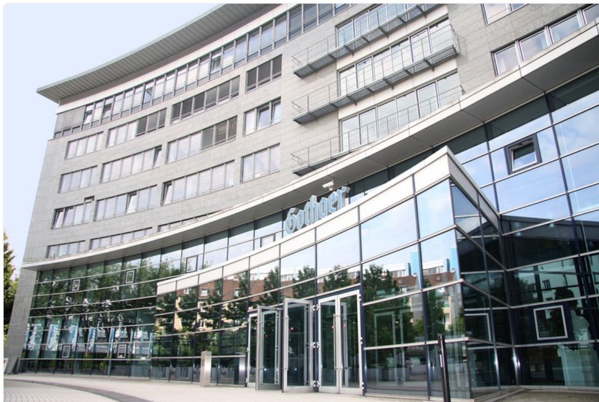
Gothaer Allgemeine Versicherung AG in der Gothaer Allee 1 in Köln
