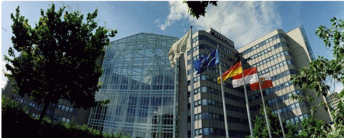
Atricom-Gebäude in Frankfurt am Main
