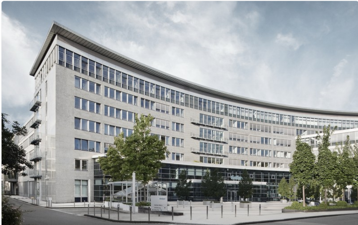
Gothaer Allgemeine Versicherung AG in der Gothaer Allee 1 in Köln
